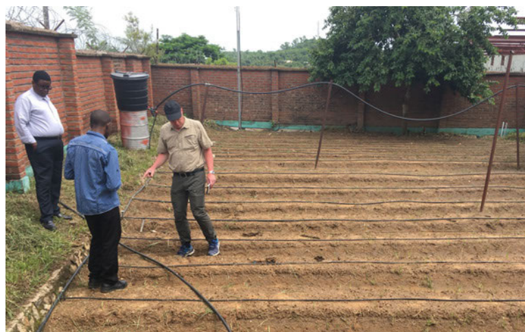
Verlegung der Polyethylenrohr-Tropfenbewässerungsinstallation in Malawi
